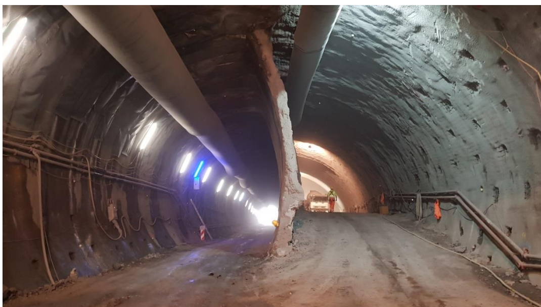
Obrázek 5: Pohled do kaverny během ražeb třetího dílčího výrubu se zachováním dělicí stěny
